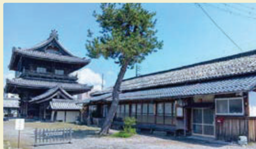
「大河ドラマ館」設置予定地(長浜別院大通寺 総会所)
